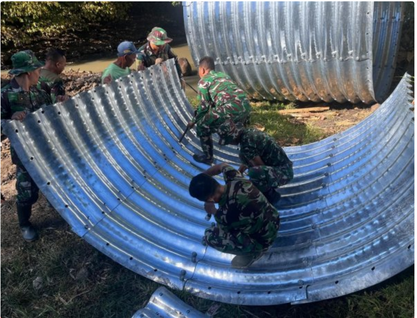
TNI Bersama Warga di Magetan Bersatu Gotong Royong Sukseskan Pembangunan Jembatan Aramco
